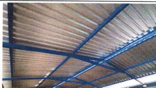
FOTO 2: SUSTITUCION DE ESTRUCTURA DE SOPORTE DE MADERA POR METAL EN MODULO DE AULAS
