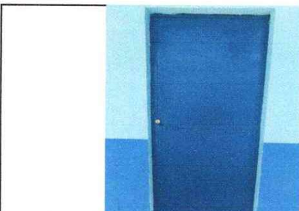
FOTO 3: FABRICACION E INSTALACION DE PUERTAS DE METAL EN MODULOS DE AULAS Y COCINA
