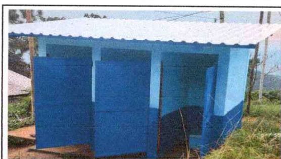
FOTO 10: MANTENIMIENTO EN PUERTA DE SANITARIO
