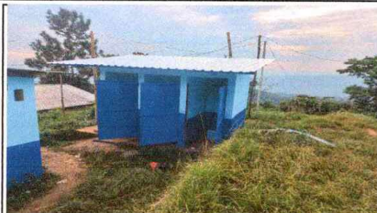
FOTO 7: SUSTITUCION DE LAMINA, POR LAMINA TROQUELADA CALIBRE 26 EN MODULO DE BAÑOS
