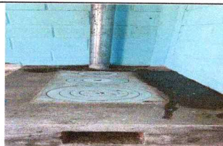
FOTO 4: SUSTITUCION DE ESTUFA RURAL (COMPLETA) INCLUYE PLANCHA Y CHIMENEA EN MODULO DE COCINA
