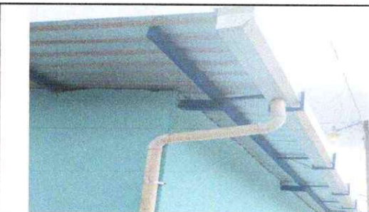
FOTO 5: SUSTITUCION DE CANAL DE METAL EN MODULO DE AULAS
