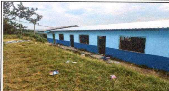
FOTO 1: SUSTITUCION DE LAMINA, POR LAMINA TROQUELADA CALIBRE 26 EN MODULO DE AULAS
